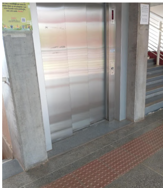
Figura 12. Piso tátil de alerta com obstáculo a frente
